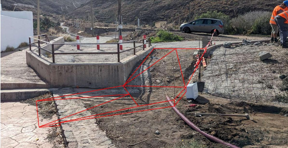
*La rampa, de 1,5 metros de ancho, se realizará con hormigón armado al igual que el resto del talud, lo cual no supone incluir nuevas partidas, solo aumento de medición, por lo tanto, no se requiere de redacción de modificado. Deberá cumplir con las pendientes establecidas para itinerarios accesibles.*
